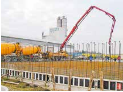
2007 Bau der Kombi- Lagerhalle 2009 Bau zweite Produktionslinie
