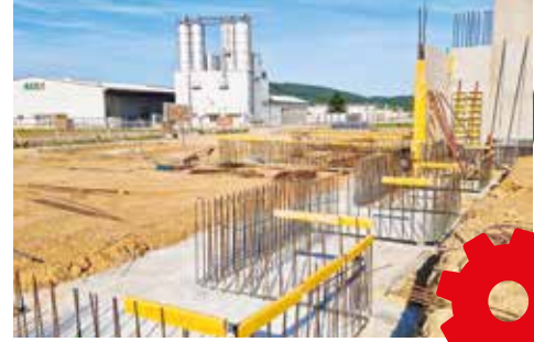
2024-25 Errichtung der neuen Lagerhalle
